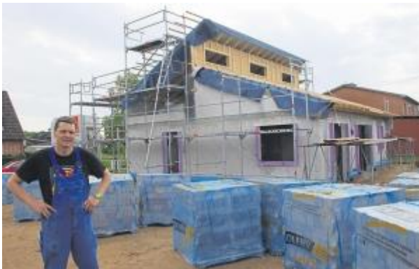
Lars Buchner freut sich über seinen Bauplatz an der Schmiedestraße. Der ist nicht von der Kontingentierung betroffen, weil es sich um eine innerörtliche Lückenbebauung handelt. Fotos: Böttiger
