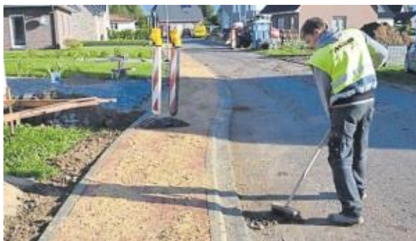
Neubaugebiet Bürgermeister-Tiessen-Ring: Alle Grundstücke sind verkauft, der Endausbau ist abgeschlossen.
