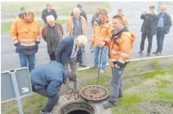
Keine Mängel: Gestern ist der neue Kreisverkehr in Lohe-Rickelshof technisch abgenommen worden, ab heute heißt es freie Fahrt. Foto: Seehausen
