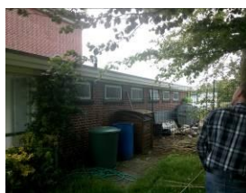
Ostansicht (1- geschossiger Anbau Ost, mit unbeheiztem Durch- gang und WCs)
