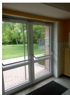
Fenster und Türen (2-fach verglast. Überwiegend aus 1982 – 85, vereinzelt er- neuert 1995, 2002, 2014)
