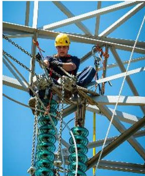
Umbeseilungen und Netzverstärkung
