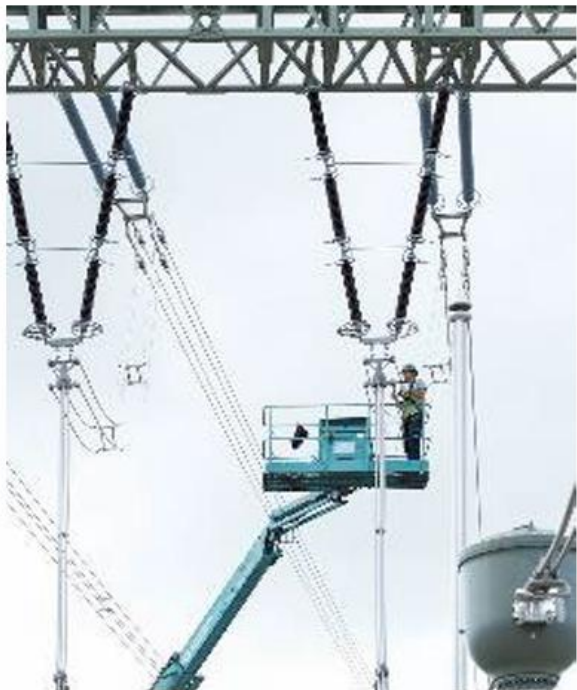
Modernisierung von Umspannwerken
