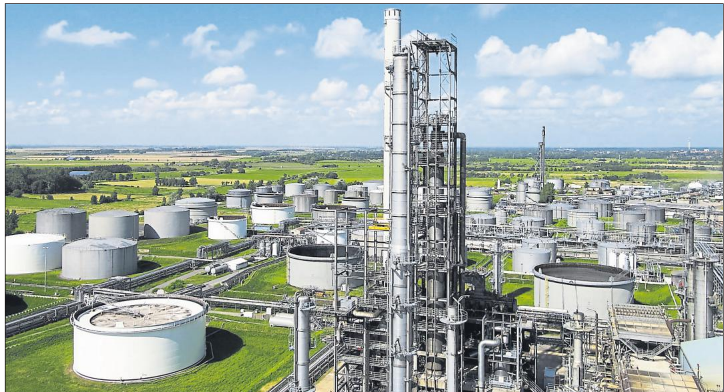
Blick aus der Luft auf das Gelände der Raffinerie Heide in Hemmingstedt.
