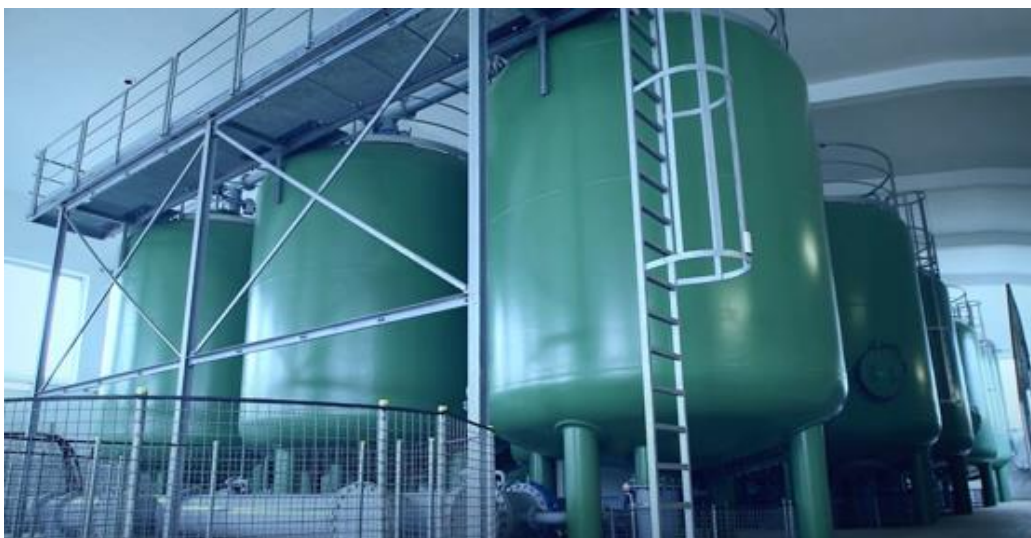
Abbildung 17: Mehrschichtfilteranlage eines Wasserwerks
