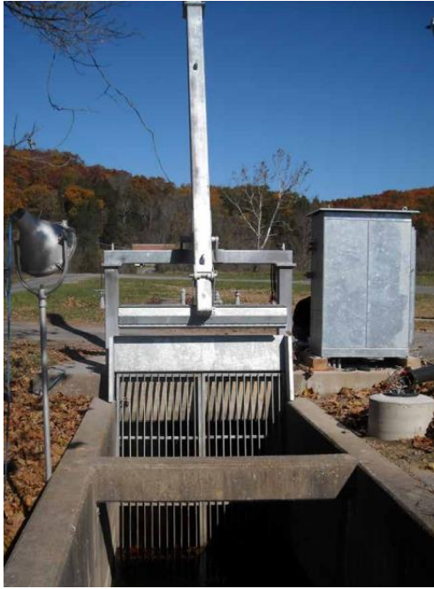
Abbildung 7: Entnahmebauwerk mit Vertikalrechen (Beispiel)
